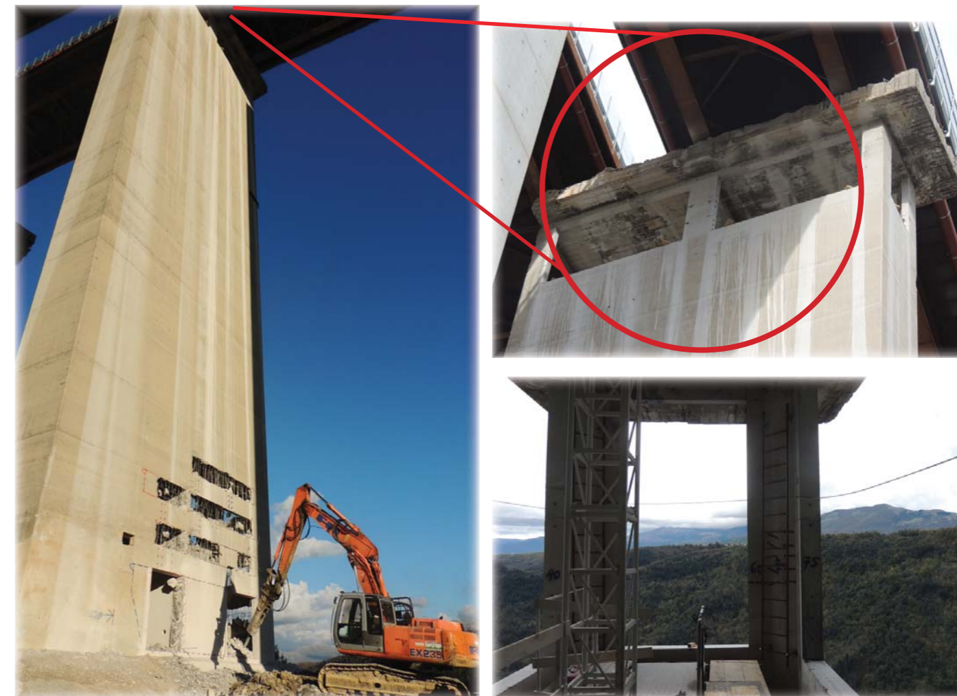
Forometrie in testa pila per la riduzione d'altezza necessaria ad eliminare il rischio d'interferenza della pila con il sovrastante nuovo impalcato, in fase di rotazione per il ribaltamento. Tagli a diamante e perforazione a secco con martelli elettrici a rotopercussione.
