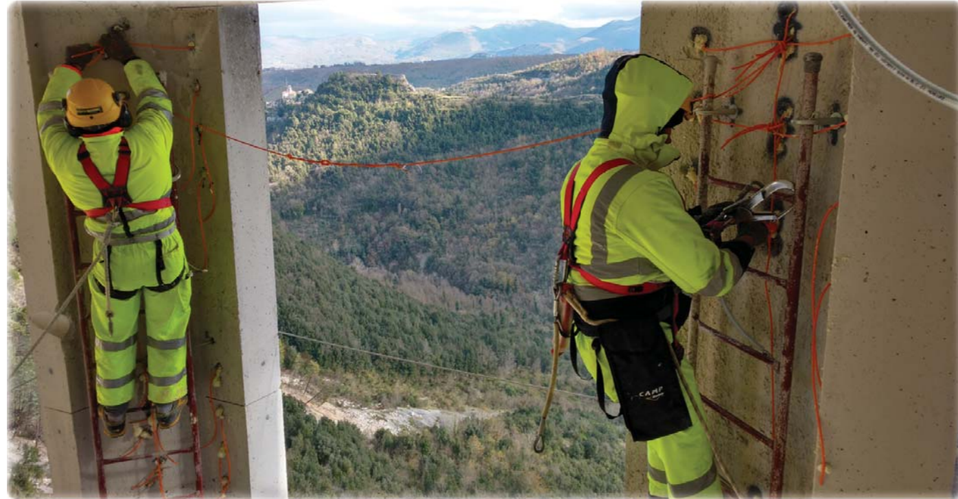
Caricamento esplosivo sulle nervature residue in testa pila.
