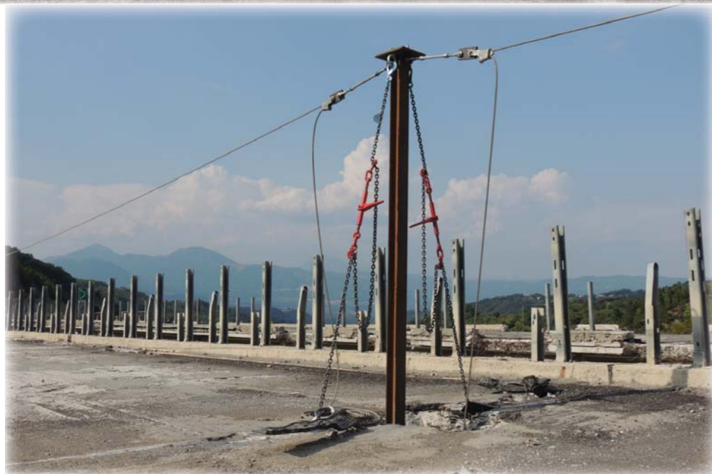
Dettaglio della linea anticaduta vincolata alle pile.
