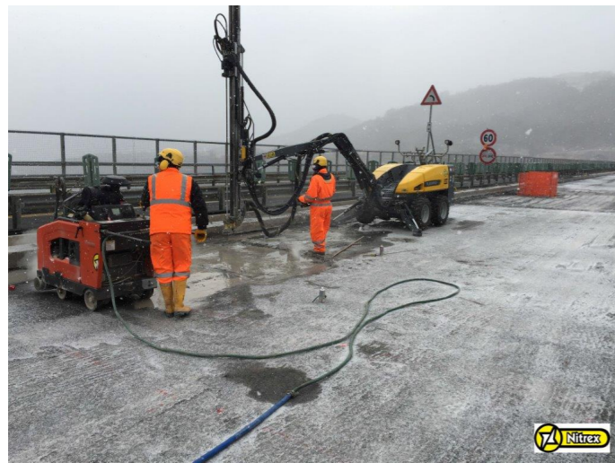
La carreggiata Sud a lavori di predisposizione per l'abbattimento completati. I coni verdi sono inseriti nei fori da mina. Tra i fori da mina la soletta tagliata a disco diamantato.
