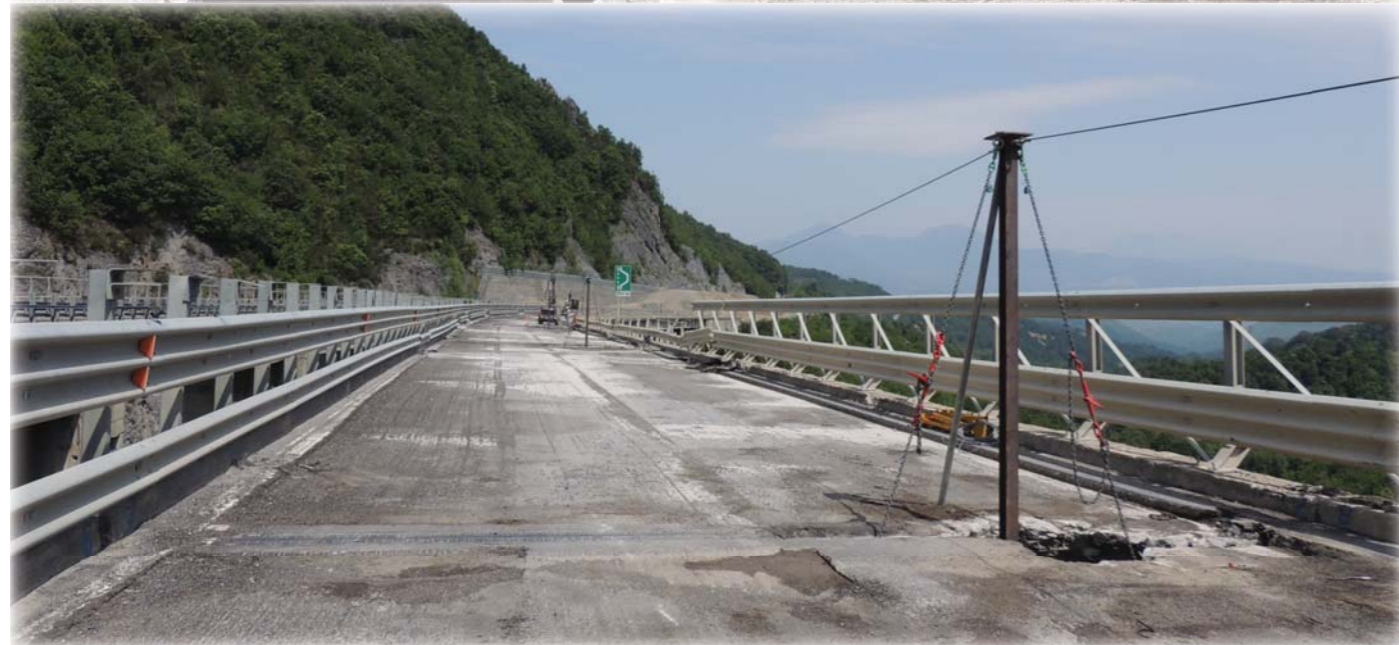
Dettaglio della linea anticaduta vincolata alle pile.
