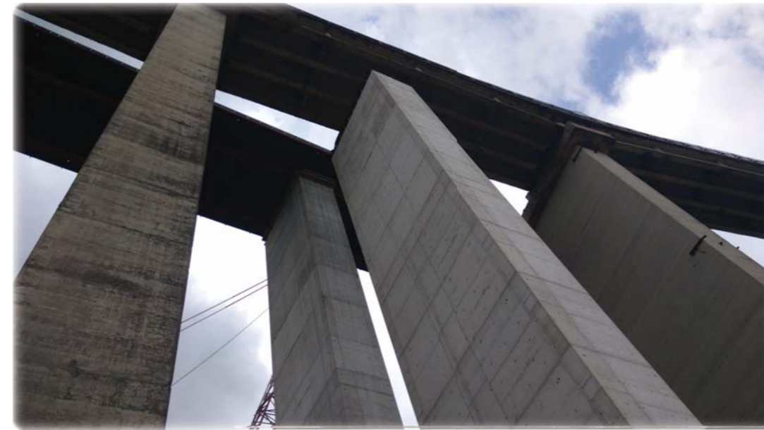
La nuova pila sotto il vecchio impalcato da abbattere, prima ...
