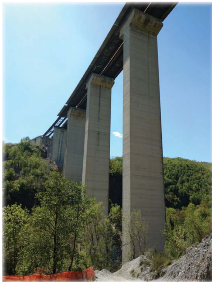
Nuova sovrastruttura del viadotto Jannello con la vecchia parzialmente demolita.
