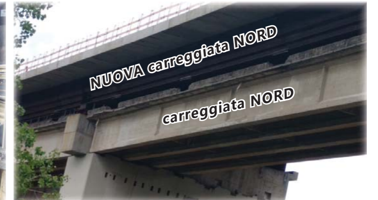
Il telaio in acciaio Corten della nuova sovrastruttura, appoggiata al vecchio piano di via già predisposto per l'abbattimento.
