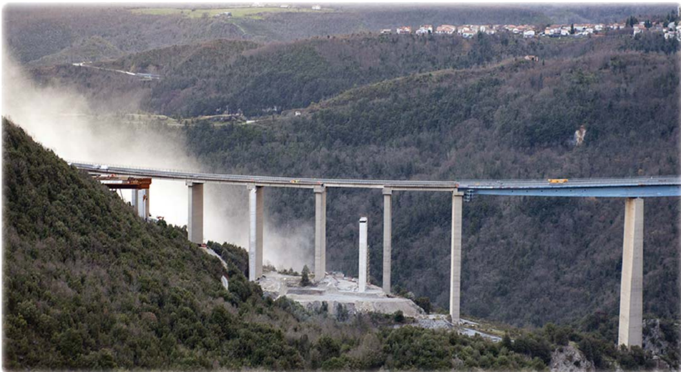
... e dopo lo sparo. L'esplosione provocò la frantumazione integrale dell'impalcato.
