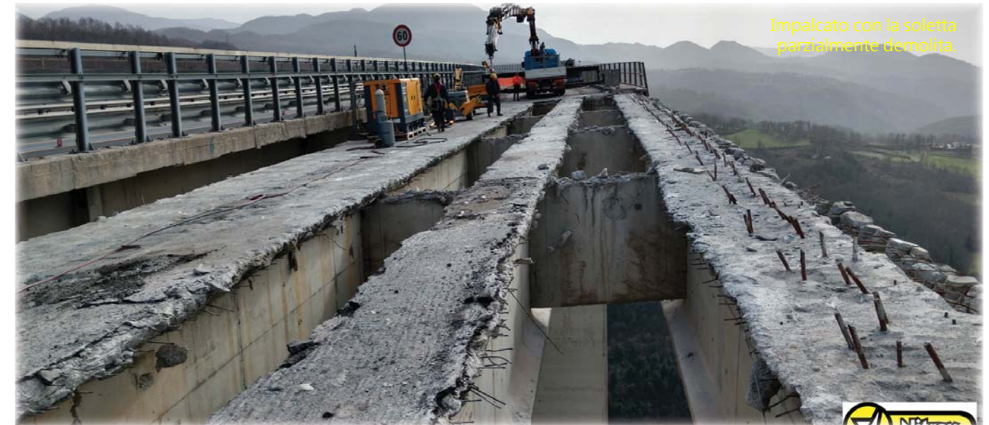
Pinza idraulica su escavatore elettrico radiocomandato, con pezzo speciale per la demolizione, "in negativo" sino a 4 metri, dei traversi precompressi di collegamento.
