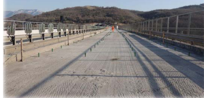
La carreggiata Sud a lavori di predisposizione per l'abbattimento completati. I coni verdi sono inseriti nei fori da mina. Tra i fori da mina la soletta tagliata a disco diamantato.
