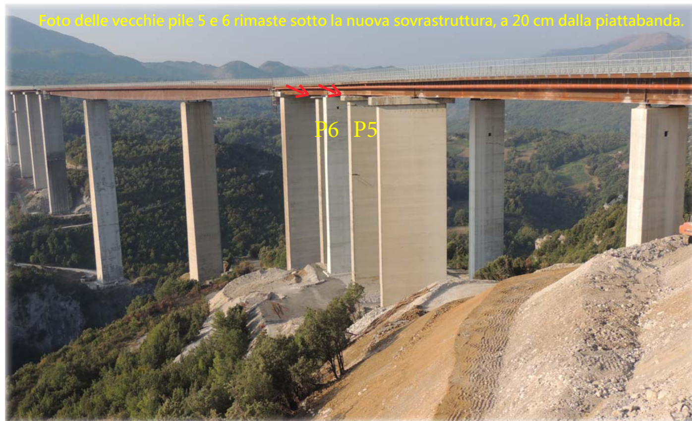
Dettaglio della Pila 6.
