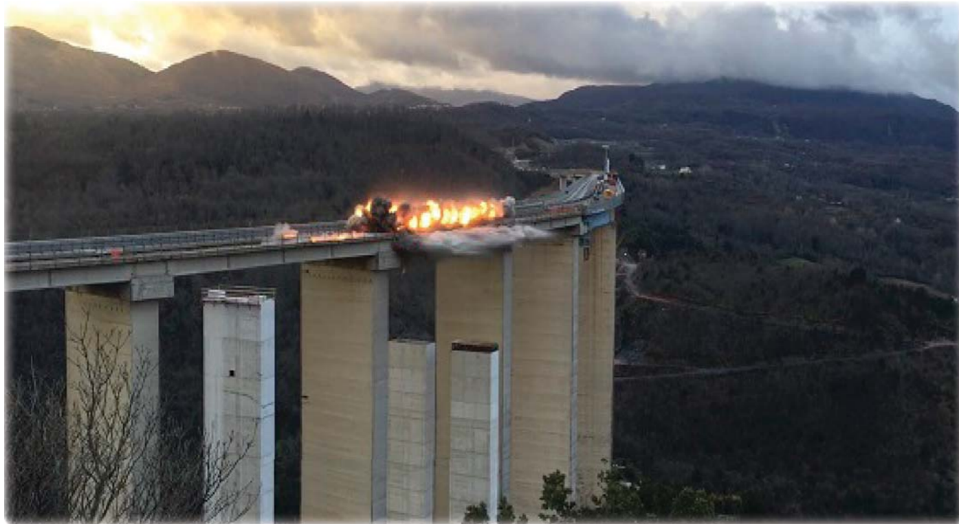
Il brillamento dell'impalcato sovrastante la nuova pila in carreggiata Sud, prima ...
